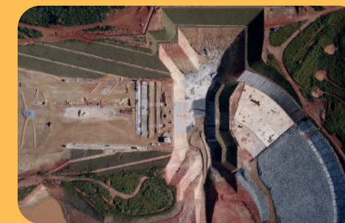
Visão geral da obra. Data: 14/05/22
